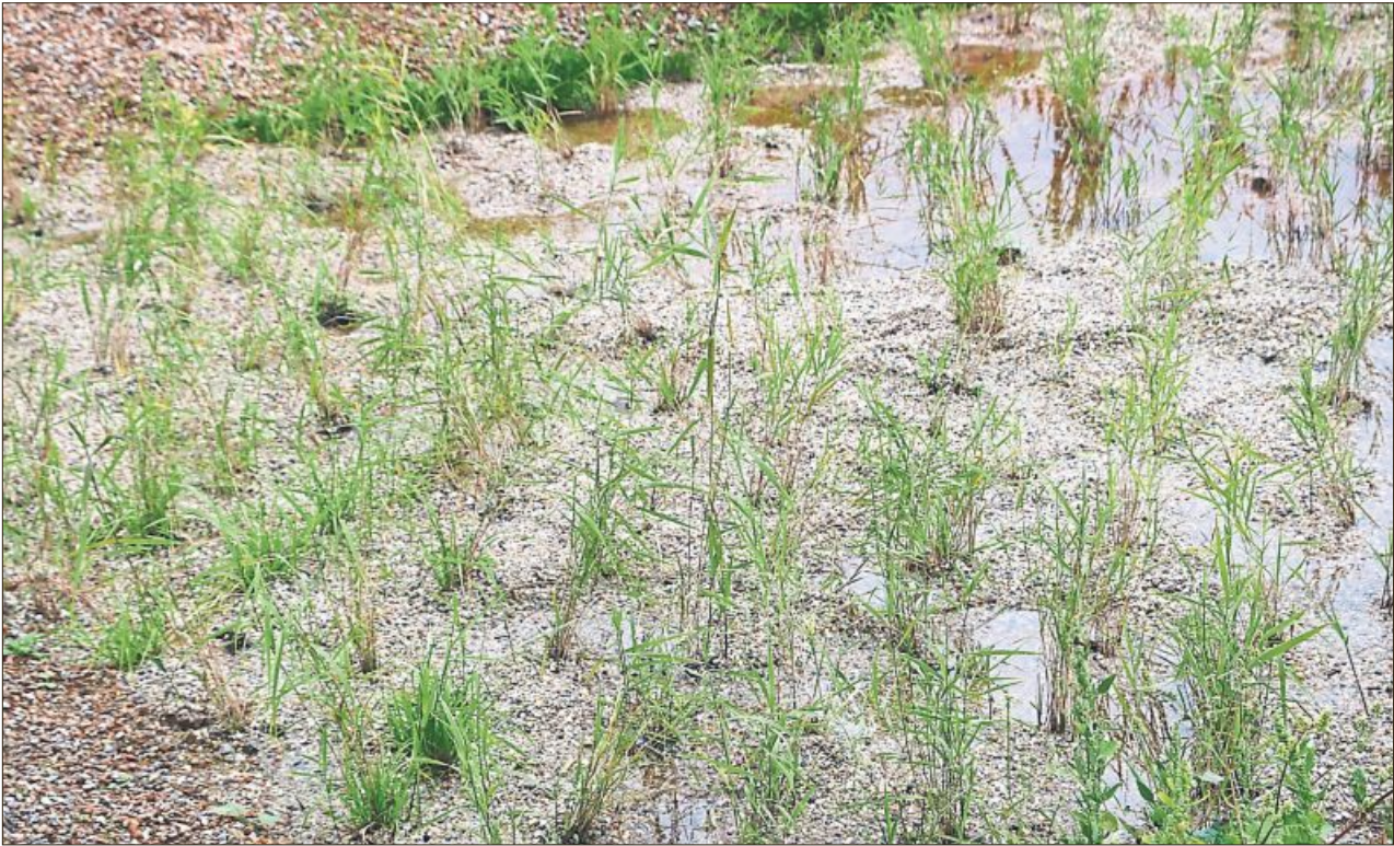
2.700 Schilfpflanzen klären ab sofort das Sickerwasser aus der Restmülldeponie.
